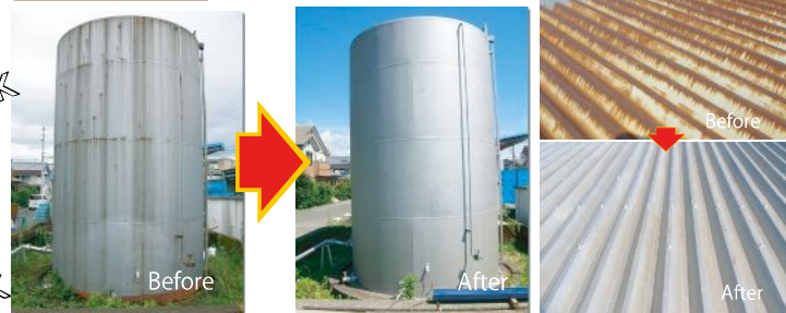
▲上塗りをせずそのままシルバー仕上りでもOK ▲部分的な塗装だけでもOK
