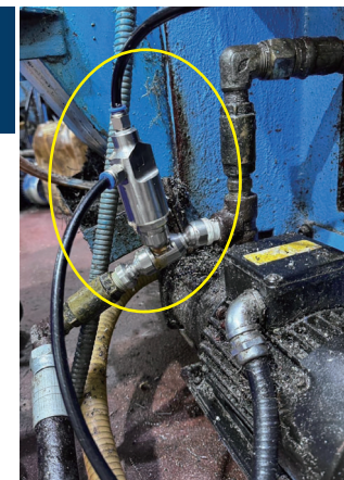
実際のメカニカルバルブ 取り付け画像
